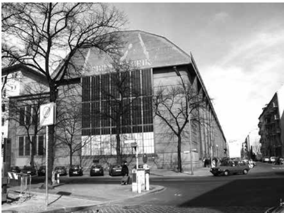
写真1 AEGタービン工場、ペーターペーレンス設計1911~1912
