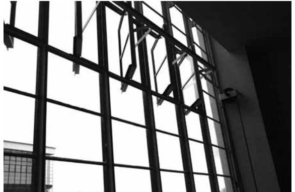
写真5 自然換気用に開閉できるガラス窓
