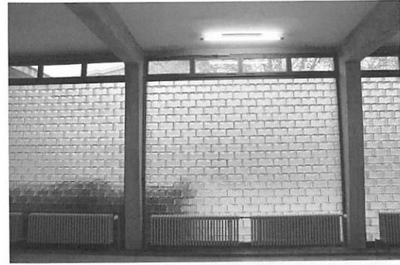
写真16 廊下の外壁に設置されたガラスブロック(上部は透明ガラスを設置し、採光の効率を上げた)
