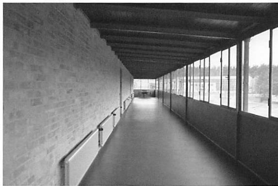
写真19 室内側に設置された放熱器
