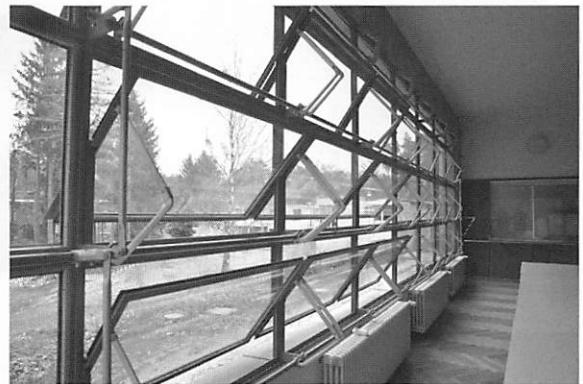
写真20 ガラス窓の自然換気用に設けられた開閉装置(デッサウのバウハウスの建物グロピウス設計)にも同様の装置がある
