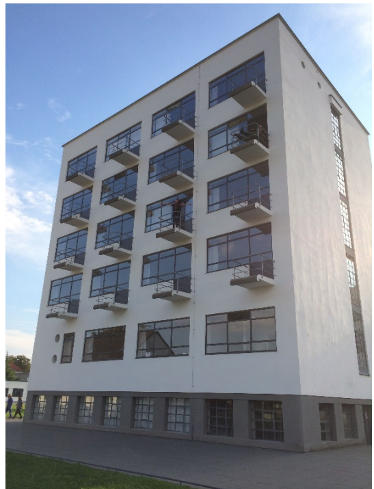
バウハウス・デッサウ校舎の旧学生アトリエ
